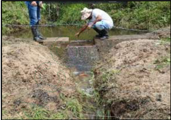
Figura 9. Fuente, captación y PTAP de la fuente “El Carmelo Parte Alta”
