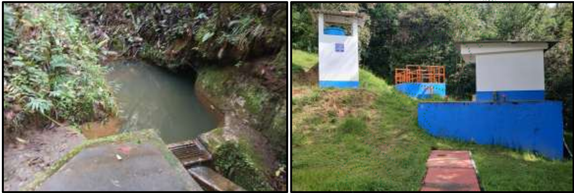
Figuras 7 y 8. Fuente, captación y PTAP de la fuente “El Carmelo Parte Alta”
