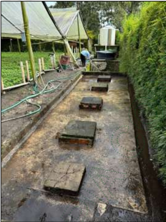
Imagen 1: Sistema de Tratamientos de Aguas Residuales Domésticas. Fuente: Andrea Rendón
