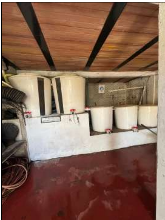
Imagen 3: Sistema de Tratamientos de Aguas Residuales No Domésticas. Fuente: Andrea Rendón
