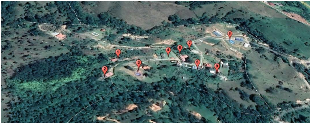
Figura 1. Predio donde se ubican las viviendas rurales
