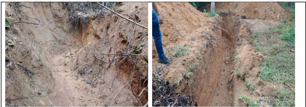
Imagen 8,9. Excavaciones realizadas en el predio con FMI- 0030248 y PK 5912004000000100232
