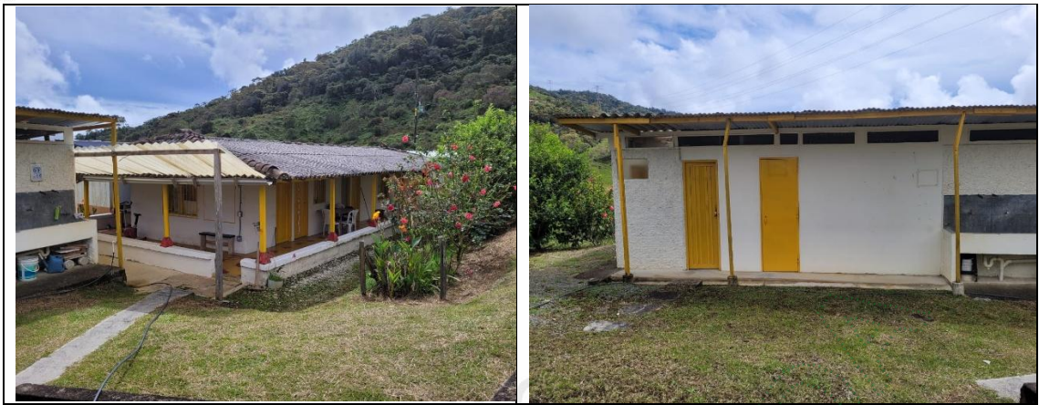
Figura 3. Estado actual de las instalaciones
