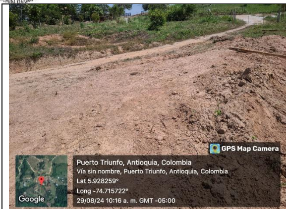
Figura 5. Intervención de cauce por vía, contigua al Lago ornamental
