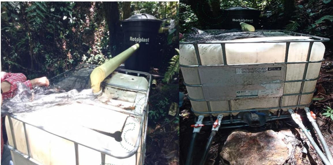
**Obra de captación tanque desarenador, almacenamiento inicial y distribución.**
