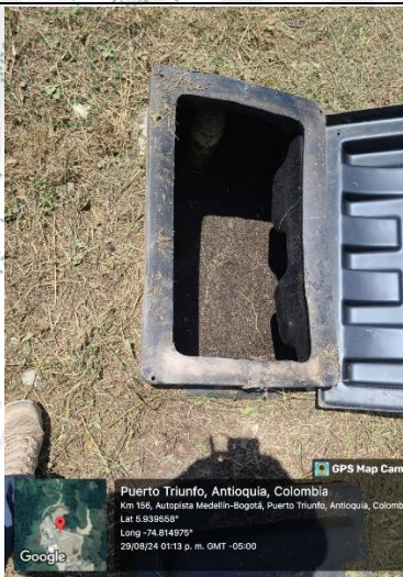
Figura 12. Estado actual primer compartimento
