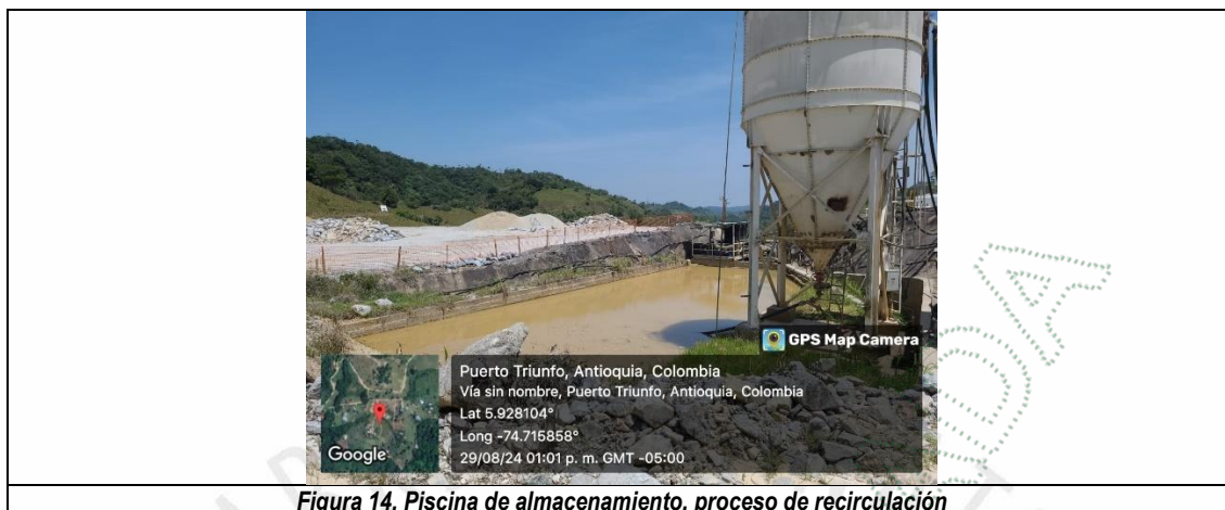
Figura 14. Piscina de almacenamiento, proceso de recirculación
