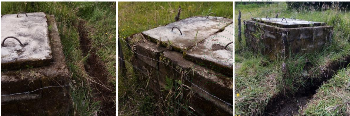
Tanques al que se le realizó mantenimiento y retiro de materiales extraños
