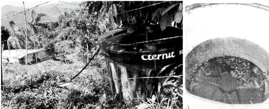
Imagen 1 y 2. Tanque de almacenamiento de agua potable y estado del agua en su interior. Cornare 2024.
