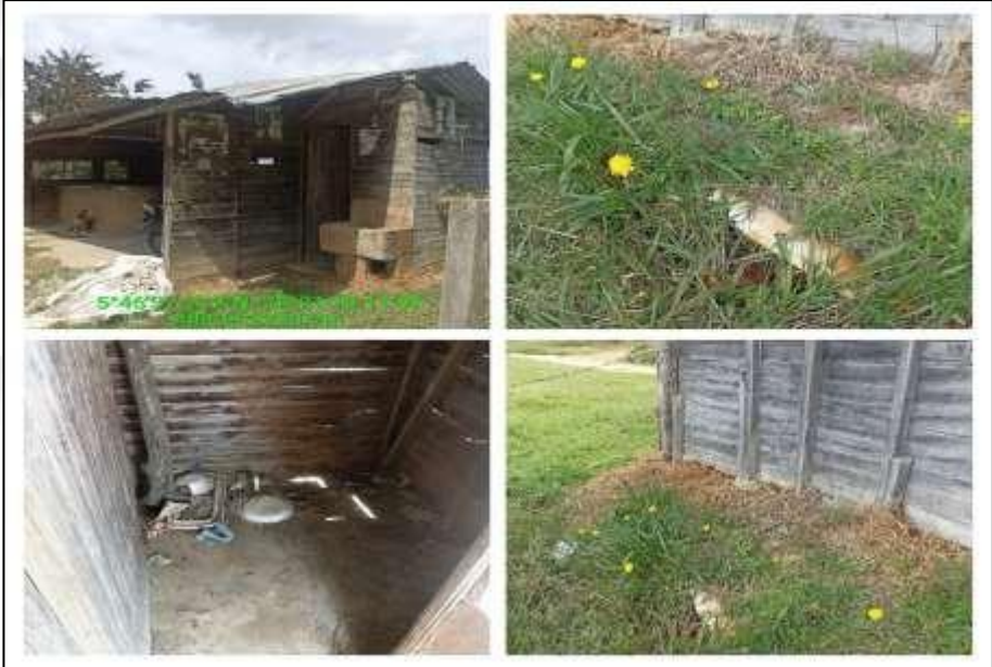
Sitio donde estaba el sanitario
