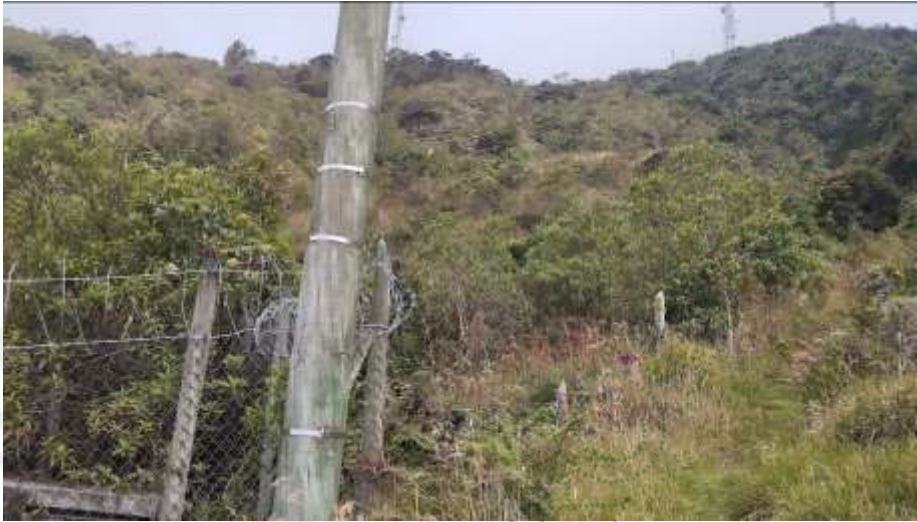
Sitio de Captación
