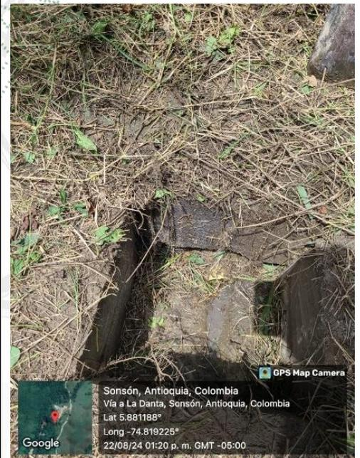
**Figura 5. Caja de salida a campo de infiltración.**
