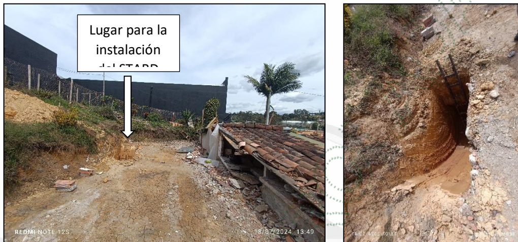
Fotografía 1. Lugar para la instalación del STARD.
