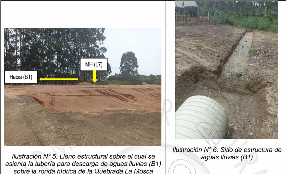
Ilustración N° 5. Lleno estructural sobre el cual se asienta la tubería para descarga de aguas lluvias (B1) sobre la ronda hídrica de la Quebrada La Mosca
