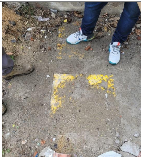
Figura 6. Trampa de grasas que trata las Aguas residuales no domésticas, clausurada
