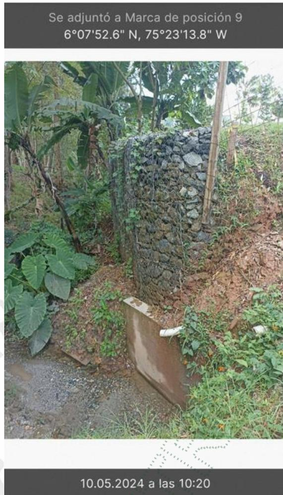
Fotografía N° 3. Muro en gaviones implementada en campo
