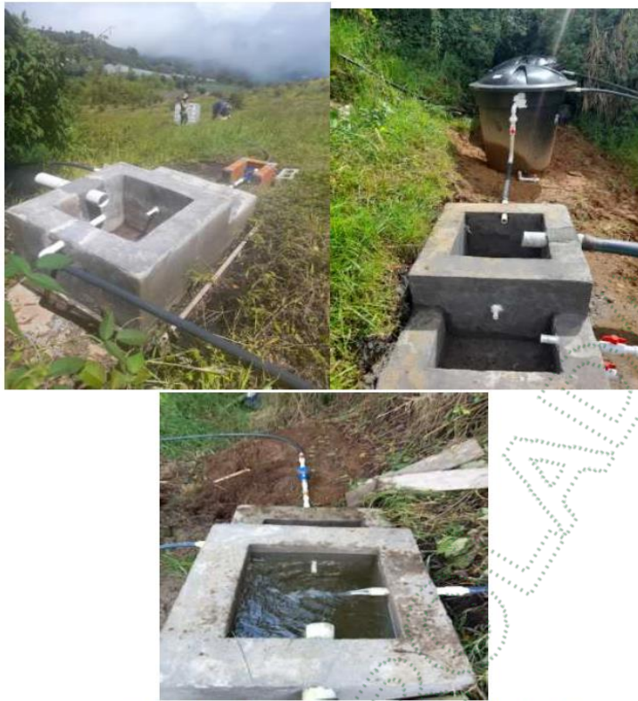
Fotografía 5. Obras de captación construidas en la UP La Ramada
