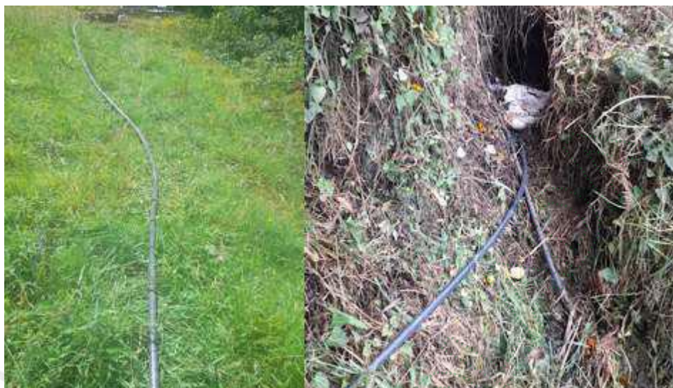
Fotografía 3. Cambios e instalación de manguera en la unidad productiva
