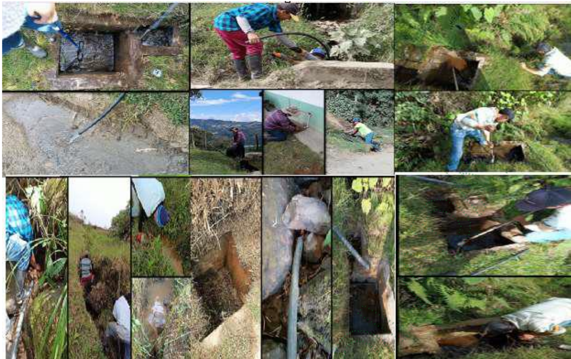
Fotografía 1. mantenimiento de las obras de captación.
