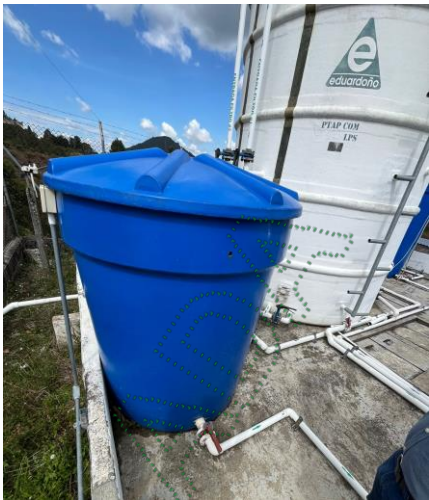
Imagen 6. Tanque de almacenamiento con dispositivo de control de flujo, SIERVAS DE LA IGLESIA (NAZARETH)
