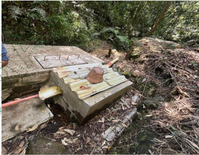
Imagen 1. Obra de captación
