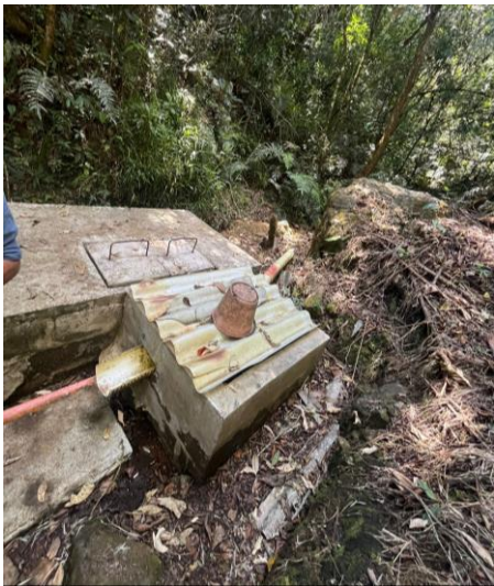
Imagen 5. Tanque de almacenamiento con dispositivo de control de flujo, Seminario Cristo Sacerdote
