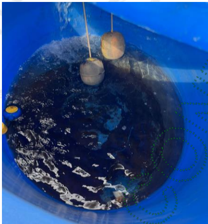
Imagen 5. Tanque de almacenamiento con dispositivo de control de flujo, Seminario Cristo Sacerdote
