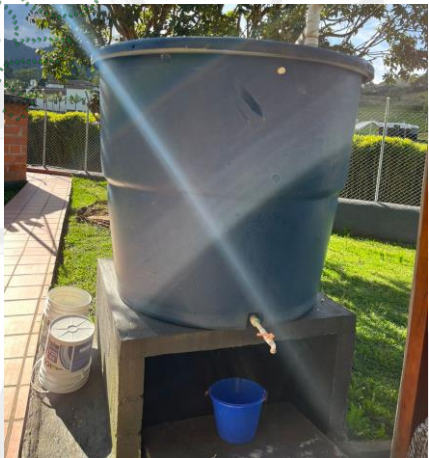
Imagen 6. Tanque de almacenamiento con dispositivo de control de flujo, SIERVAS DE LA IGLESIA (NAZARETH)
