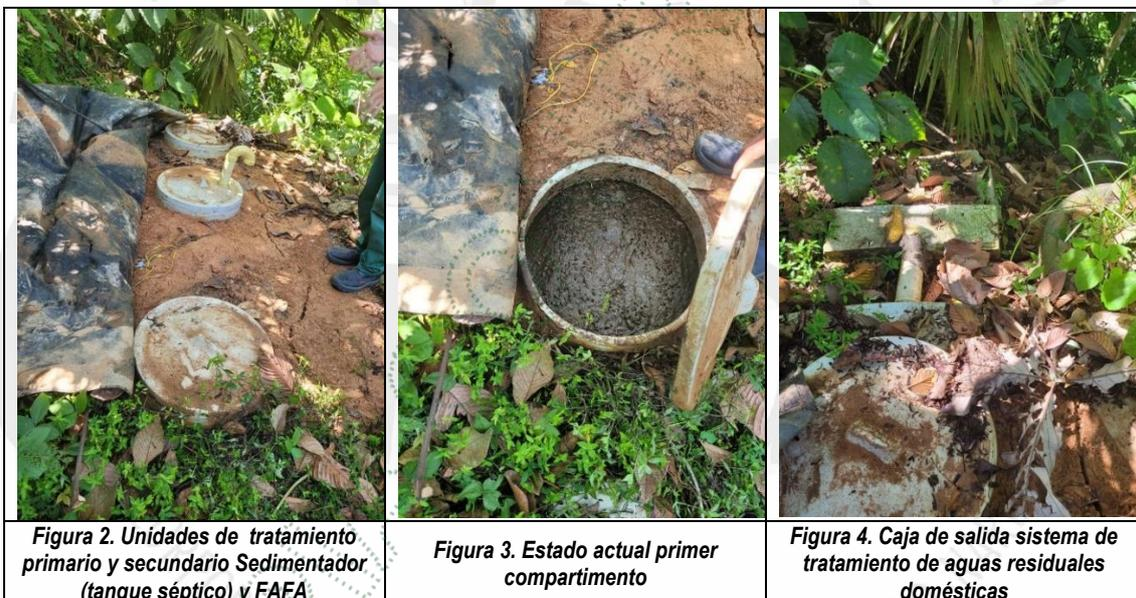
**Figura 2. Unidades de tratamiento primario y secundario Sedimentador (tanque séptico) y FAFA**
