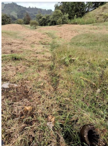
Imagen 2. Aguas abajo del punto de captación.
