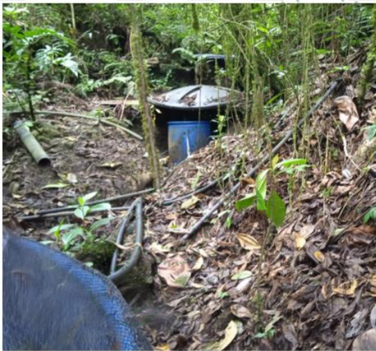
Imagen 1. Obra de captación artesanal almacenamiento
