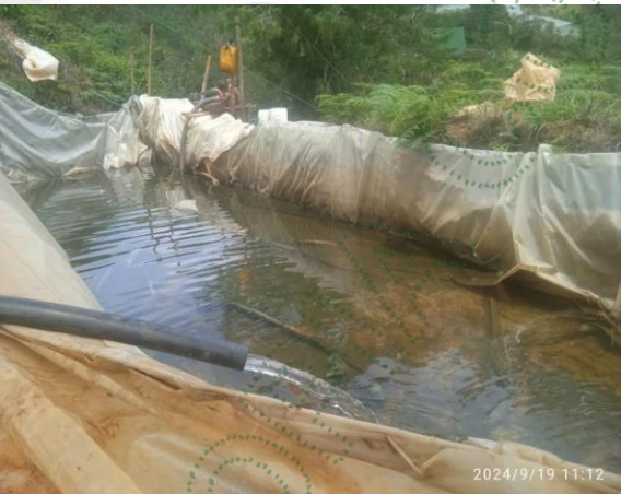
Imagen 3. Tanque de almacenamiento artesanal.
