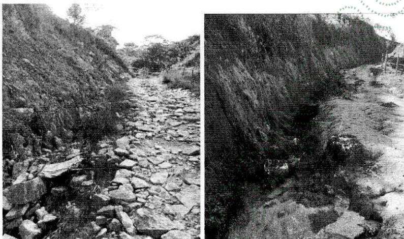
Fotos 3 y 4: Taludes cicatrizados y revegetalizados. 2024.
