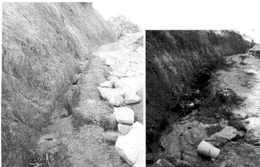
Fotos 1 y 2: implementación de cunetas. 2024.
