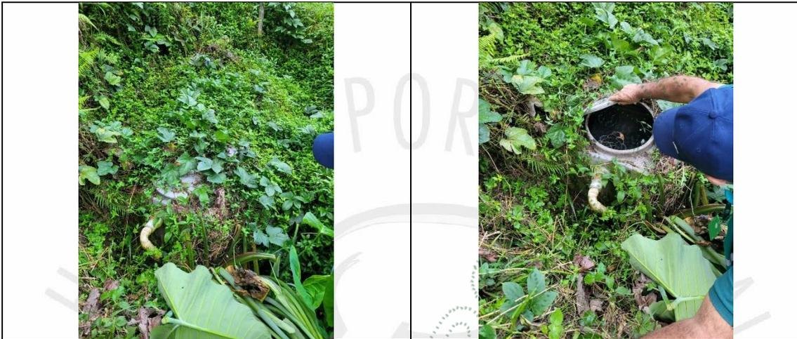
Figura 6. Descarga de las aguas residuales domésticas sobre fuente hídrica sin nombre
