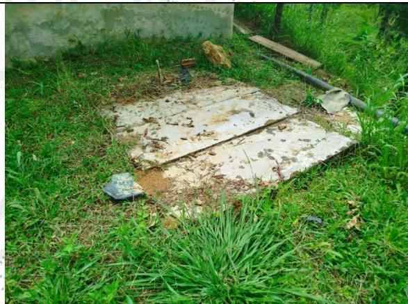
**Figura 7:** Pozo séptico elaborado en mampostería
