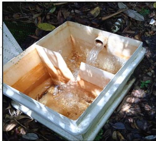
**Imagen 1: Obra de control de caudal implementada para la fuente “Quebrada El Bosque”**
