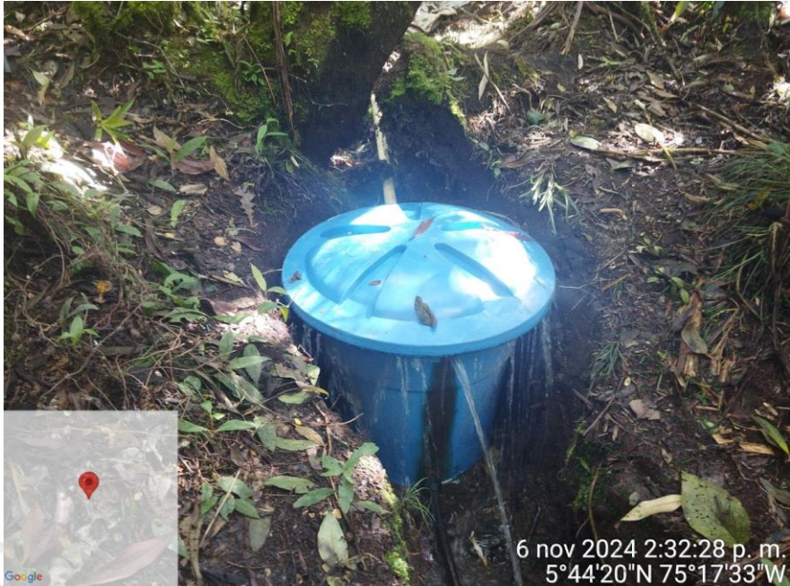
Desarenador luego de la cámara de toma directa
