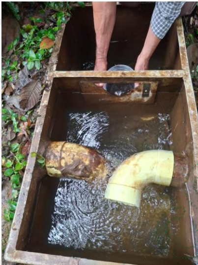
Imagen 3. Obra de captación y control.
