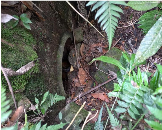
Imagen 1. Salida del recurso del box culvert
