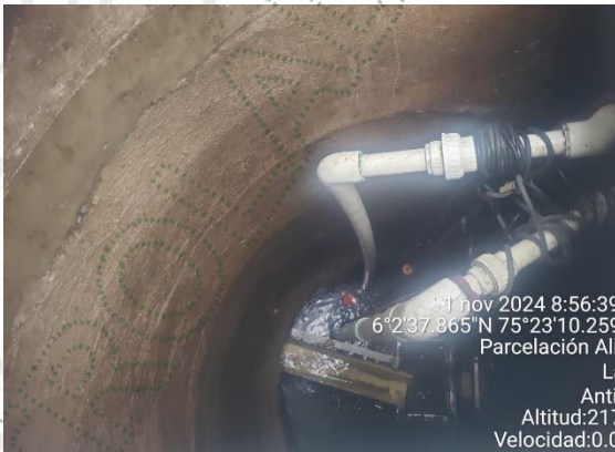
Fotografía 2. Interior del MH ubicado en el Lote 24. Instalación de dos motobombas.
