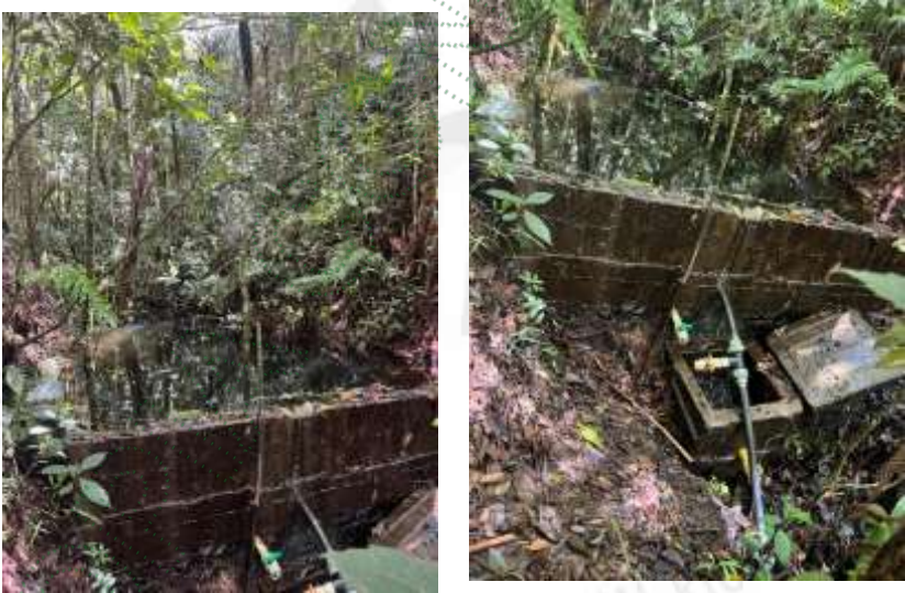
Imagen 1. Obra de captación y control de caudal implementada
