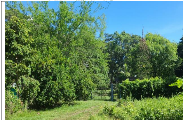
Figura 2. Entrada a la Planta de tratamiento de aguas residuales del Corregimiento de Puerto Perales
