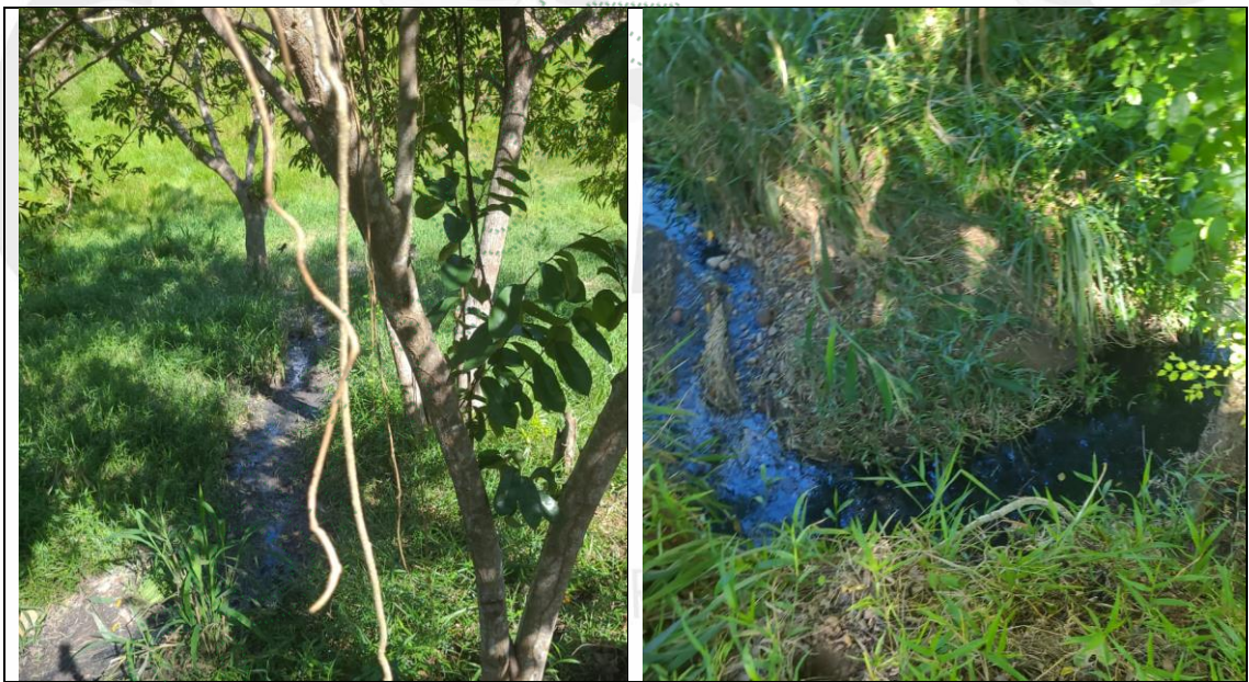
Figura 8. Descargas directas sin tratamiento previo, debido a reboses en las cámaras de inspección y fallas en la infraestructura del sistema de alcantarillado
