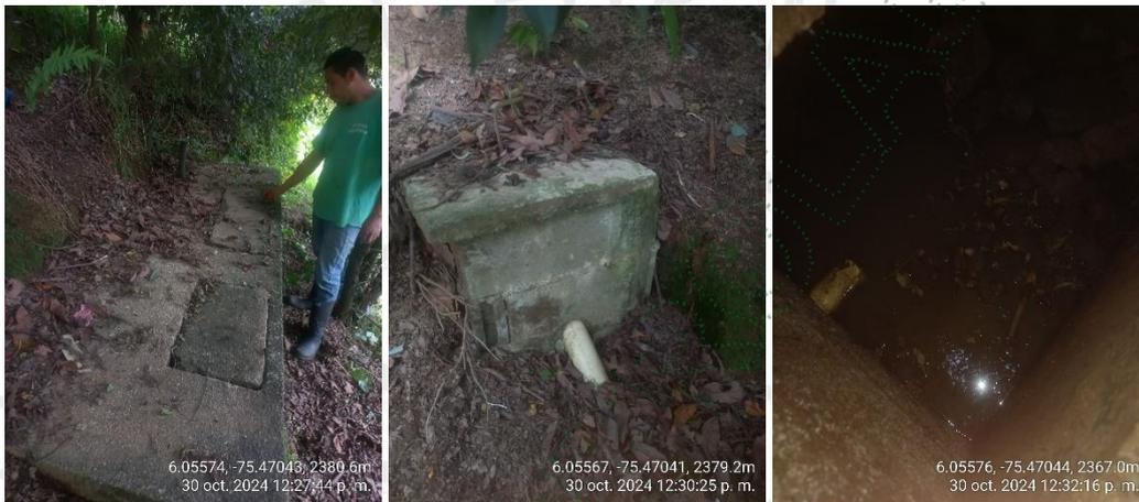
**STARD 2:** este sistema es usado en promedio por cuatro (4) personas entre permanentes y transitorias, se puede observar que no está funcionando de forma correcta por falta de mantenimiento, hay presencia de larvas de dípteros en el F.A.F.A. No se pudo observar el campo de infiltración por lo que es necesario señalar el inicio y final del mismo.
