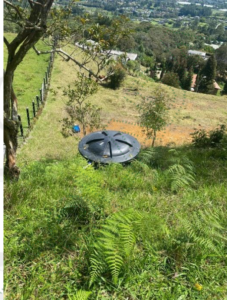
Figura 6. Tanque de almacenamiento
