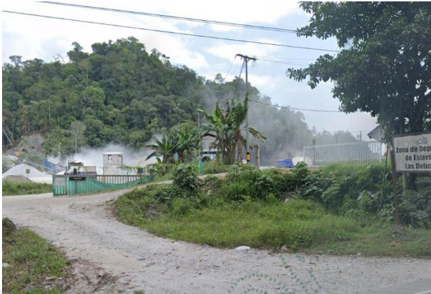
Figura 2. Entrada Zona de Depósitos de estériles Las Delicias
