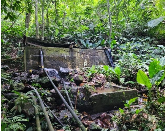
Figura 6. Tanque de almacenamiento existente
