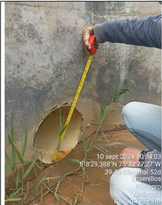
Fotografía N° 1. Estructura de descarga de aguas lluvias construida con tubería de 0.45 m
