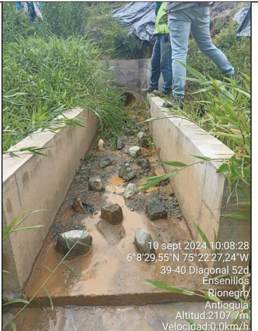
Fotografía N° 2. Estructura de descarga y canal de disipación construidos
