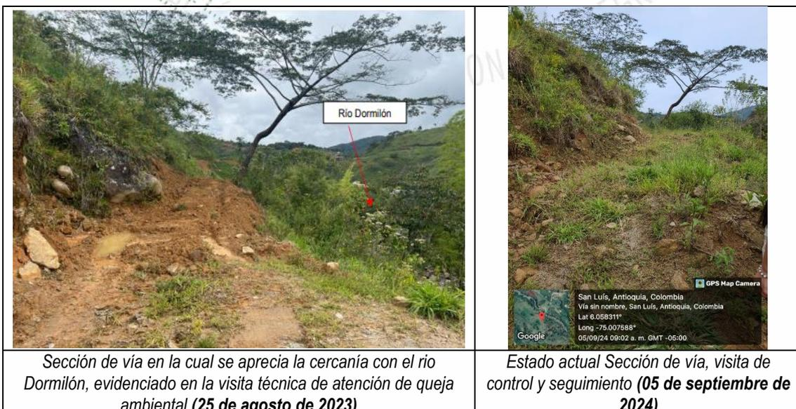
2. Con relación a los taludes expuestos, se observaron recubiertos de material vegetal, sin embargo, en la sección vial se observó deposición de materiales en la superficie terrestre (principalmente suelo y rocas) debido a procesos erosivos y de socavación por desprendimiento de tierra y deslizamiento.
