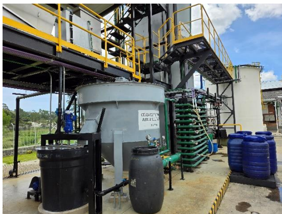
Sistema de tratamiento de aguas residuales mixto (ARD y ARnD)
