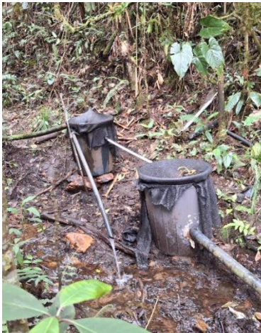
Imagen 2. Captación y Control
