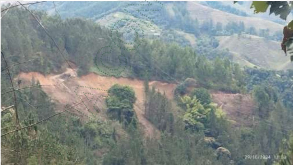
Vista general de Taludes y disposición de estériles del movimiento de tierras en la ampliación del camino
