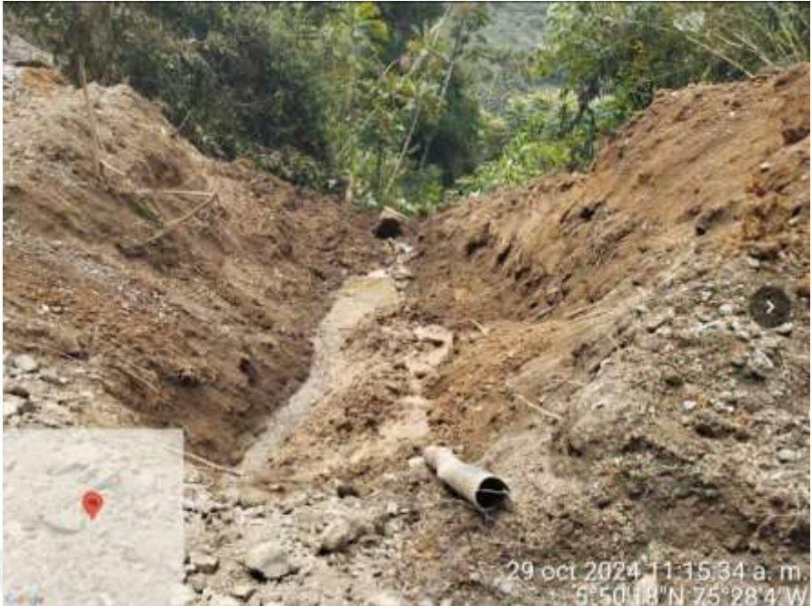
Cruce de fuente en las coordenadas -75°28'4" y 5°50'18", tubo instalado en Novafort de 8 pulgadas
