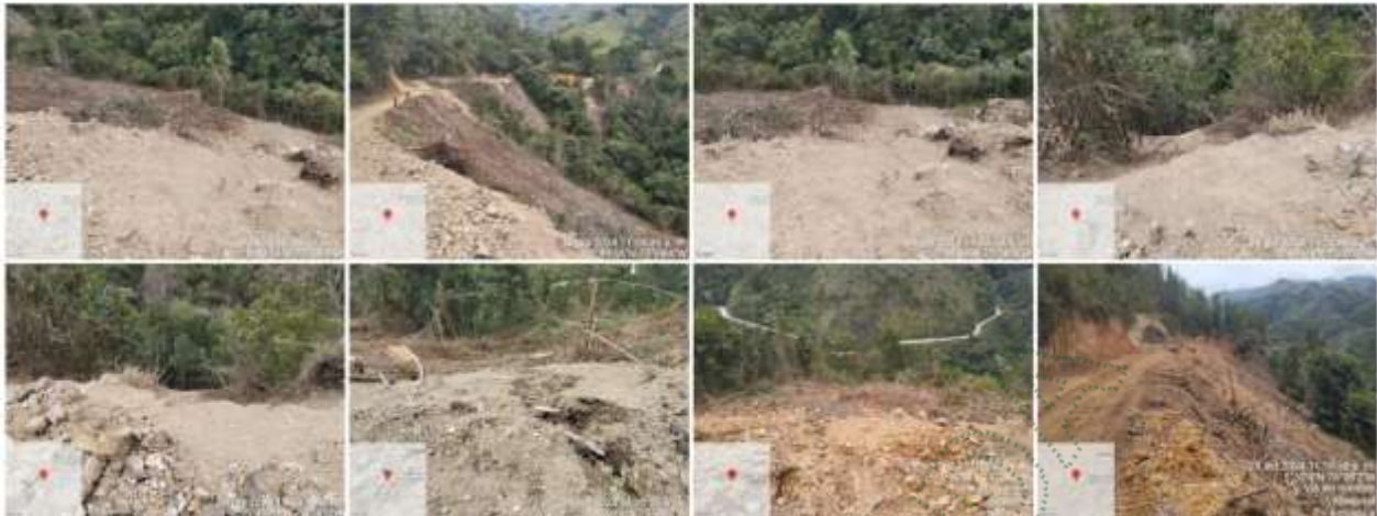
Vista de varios puntos de disposición de estériles, y en la parte baja se observa la quebrada Las Yeguas.
