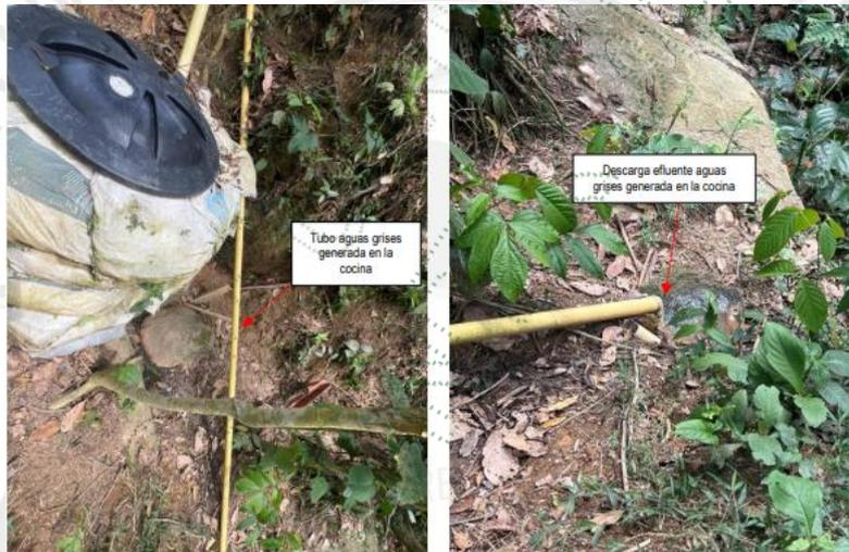
Foto 3 y 4. Tubo y descarga de las aguas residuales generadas en la cocina
