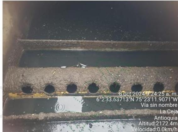
**Fotografía 4.** Canaletas niveladas y funcionando
