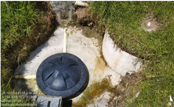
Imágenes relacionadas con el Sistema de Tratamiento de Aguas Residuales Domésticas STARD y caja de aforo.
