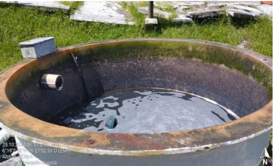
Imágenes relacionadas con el Sistema de Tratamiento de Aguas Residuales Domésticas STARD y caja de aforo.
