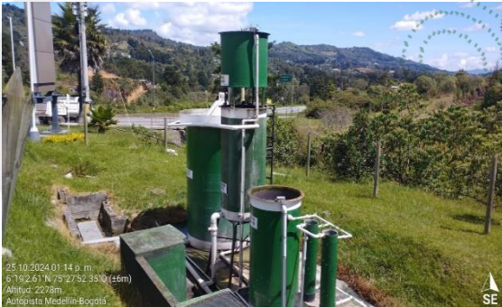
Imágenes relacionadas con el Sistema de Tratamiento de Aguas Residuales Domésticas STARD y caja de aforo.
