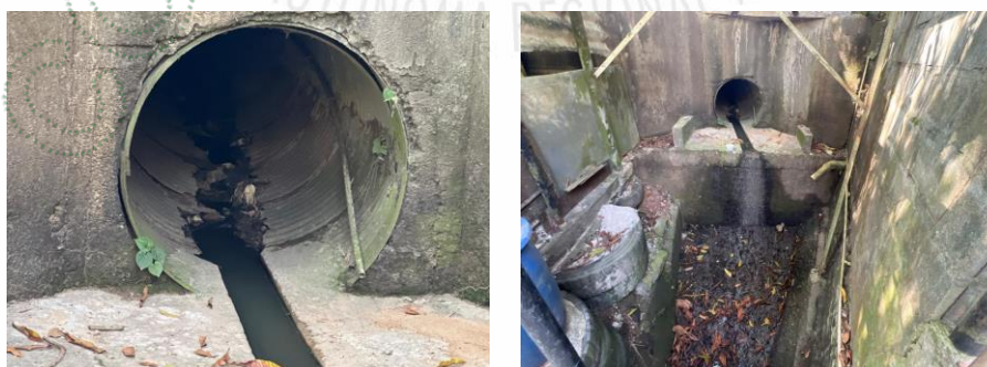
Figura 3. Descole de obra hidráulica transversal de la vía por donde se conduce el efluente del vertimiento proveniente del pozo séptico 1. Fuente: Cornare 2024
