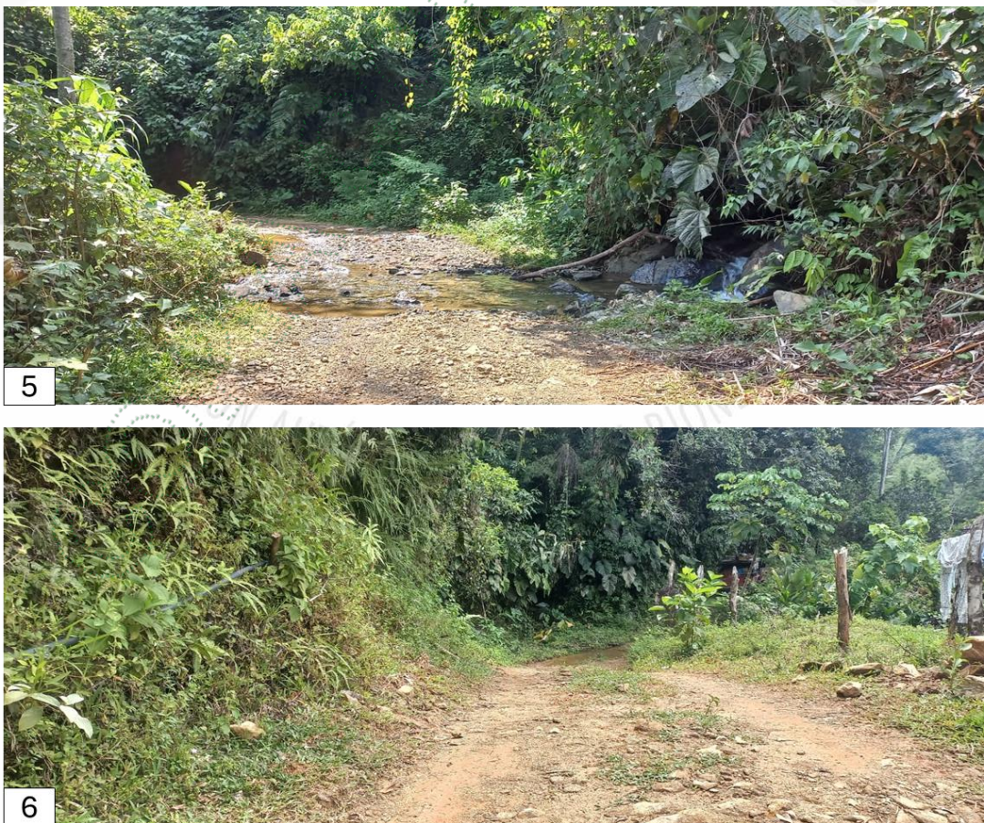
Figura 5 y 6: Apertura de la vía. Fuente: Cornare, 2024
