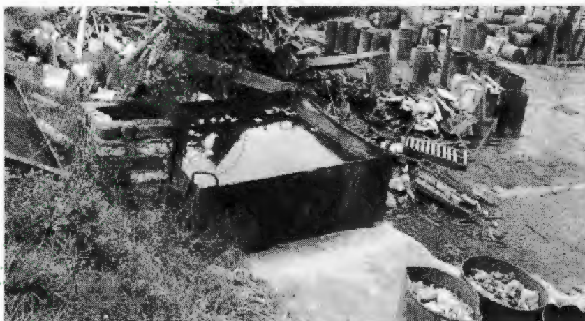
Fotografía 13: Suelo impregnado de residuos de grasa direccionados a una sistema de conducción de aguas lluvias
