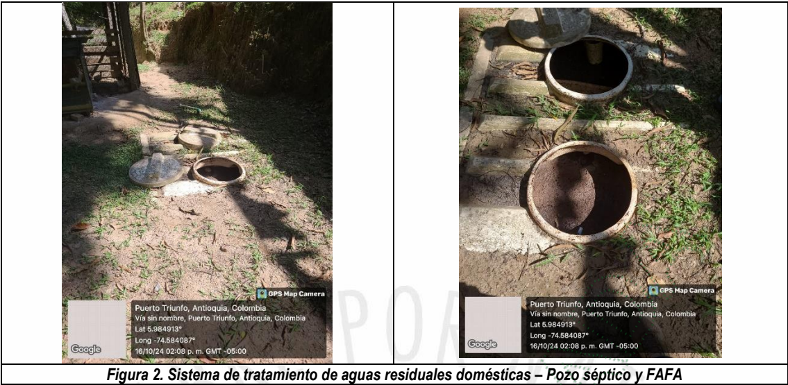
Figura 2. Sistema de tratamiento de aguas residuales domésticas – Pozo séptico y FAFA
