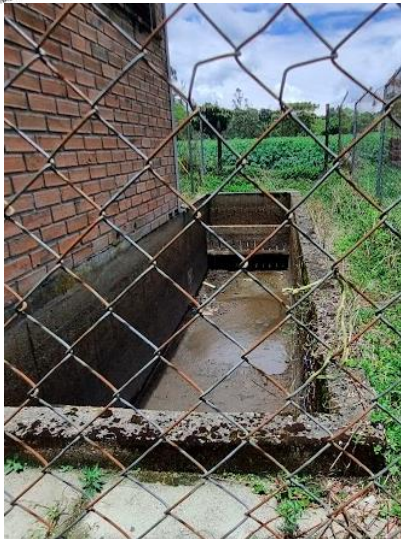
Imagen 2. Tanque desarenador.
