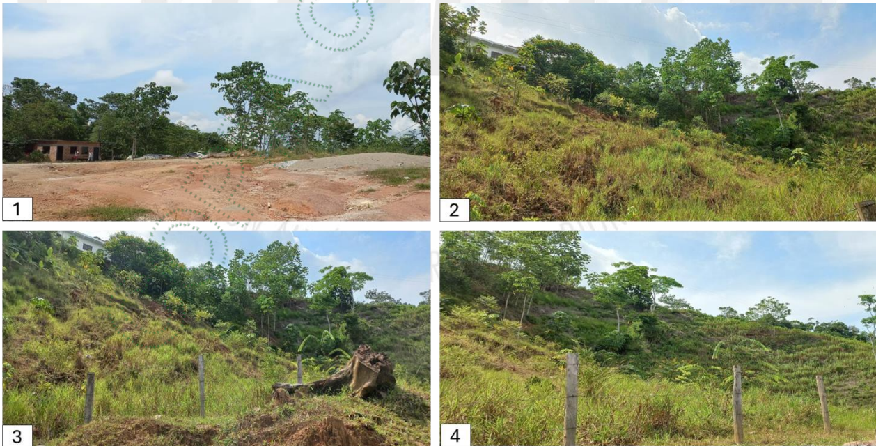
Figura 1: Explanación generada por el movimiento de tierra en el 2022.
